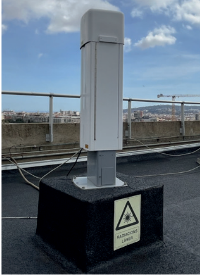
Figura 3. Ceilòmetre Vaisala CL-31 instal·lat a la Facultat de Física de la Universitat de Barcelona (Font: J. Bech).
